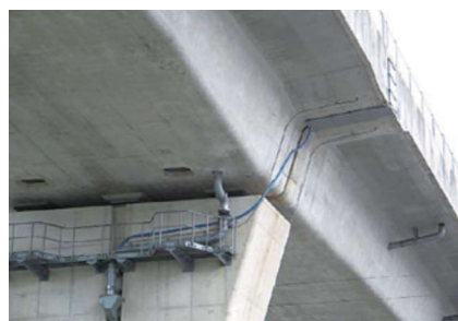
高架下漏水対策
