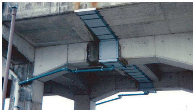
高架橋目地部
