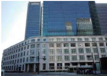
【再アルカリ化工法 施工例】
