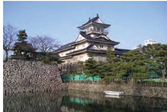
【再アルカリ化工法 施工例】
