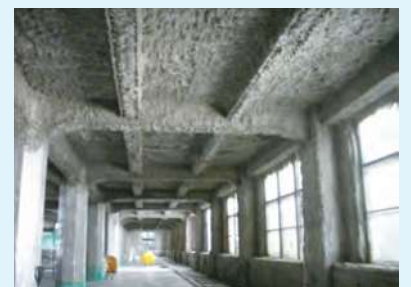
施工例(建築物内部)
