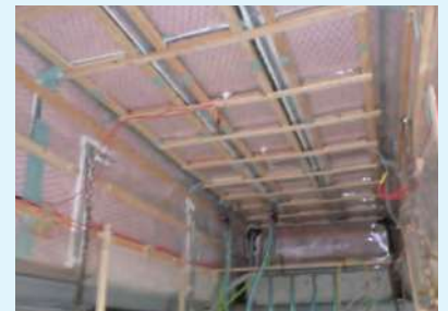
施工例(橋梁上部工)
