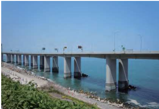
【脱塩工法 施工例】
