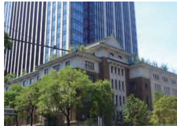
【再アルカリ化工法 施工例】
