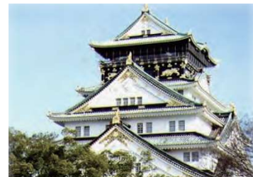
【再アルカリ化工法 施工例】
