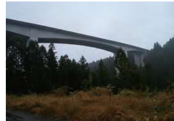
【脱塩工法 施工例】
