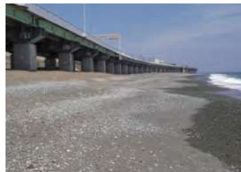
【脱塩工法 施工例】
